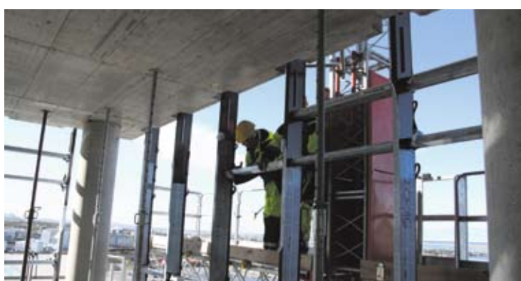
Mikinn búnað þarf til þegar verið er að klæða byggingu gleri.
