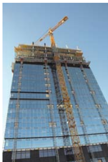
Turninn hækkar smátt og smátt og glerklæðningin fylgir á eftir.
