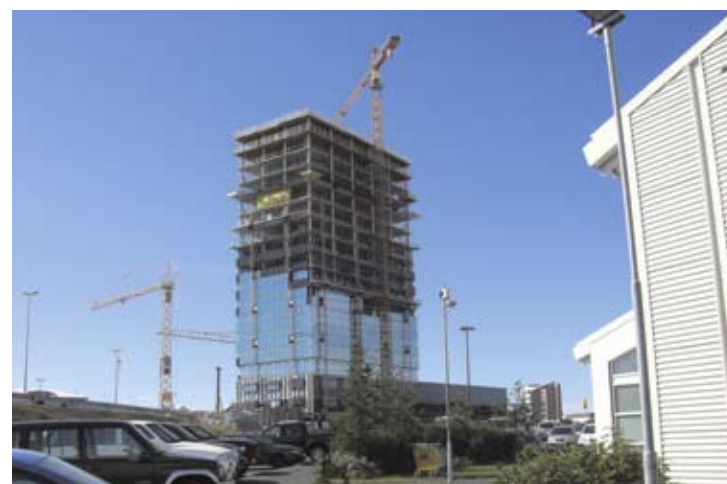
Turninn hækkar smátt og smátt og glerklæðningin fylgir á eftir.
