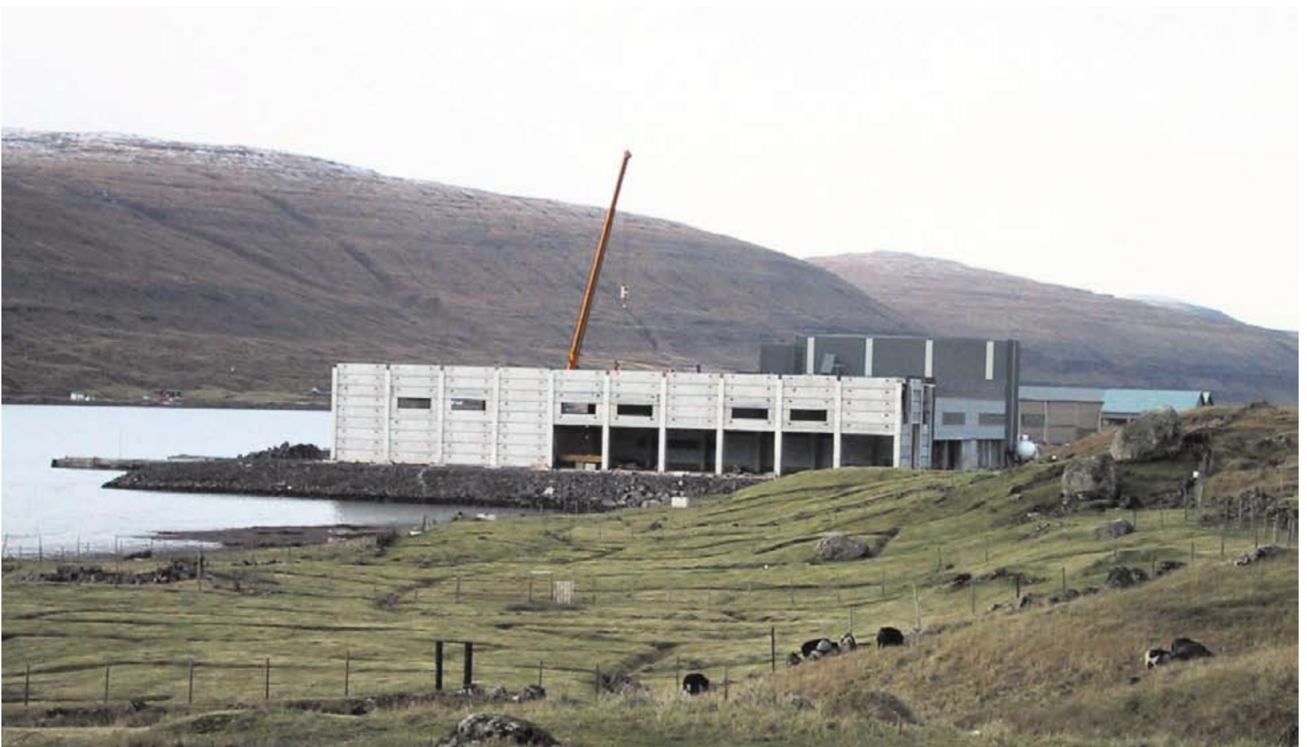
Frá byggingu verksmiðjunnar í Færeyjum.
