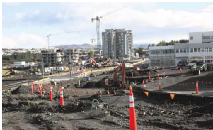
Kraftur í uppbyggingunni í Kópavogi. (Mynd: Krissy)
