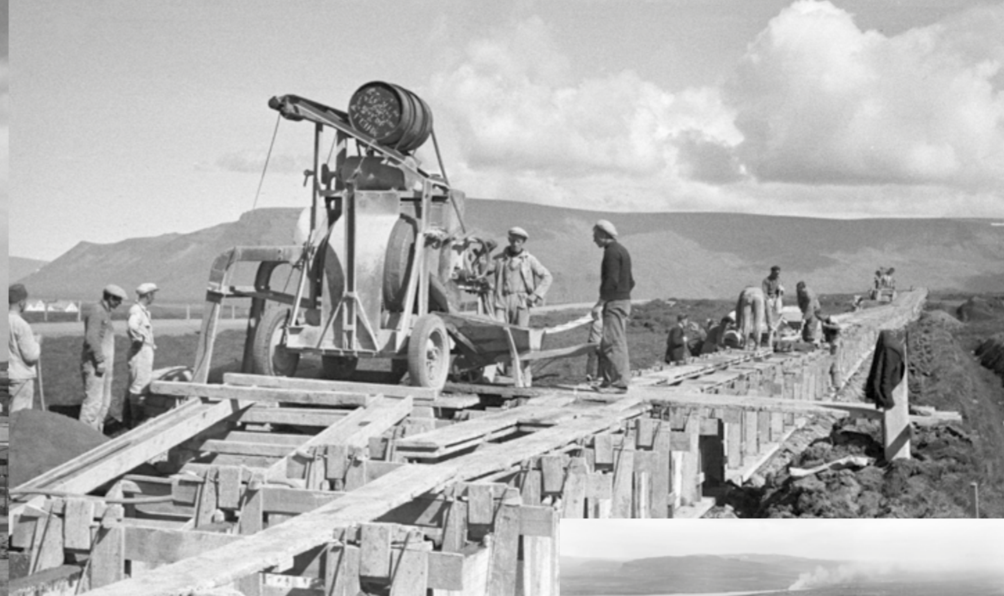
Líkelega um 1942-1943, hitaveitustokkur steyptur í útjadrí Reykjavíkur. Verkamenn við vinnu. Lengst til vinstri sést glitta í Korpúlfsstaði. Photographer: Helgi Sigurðsson
