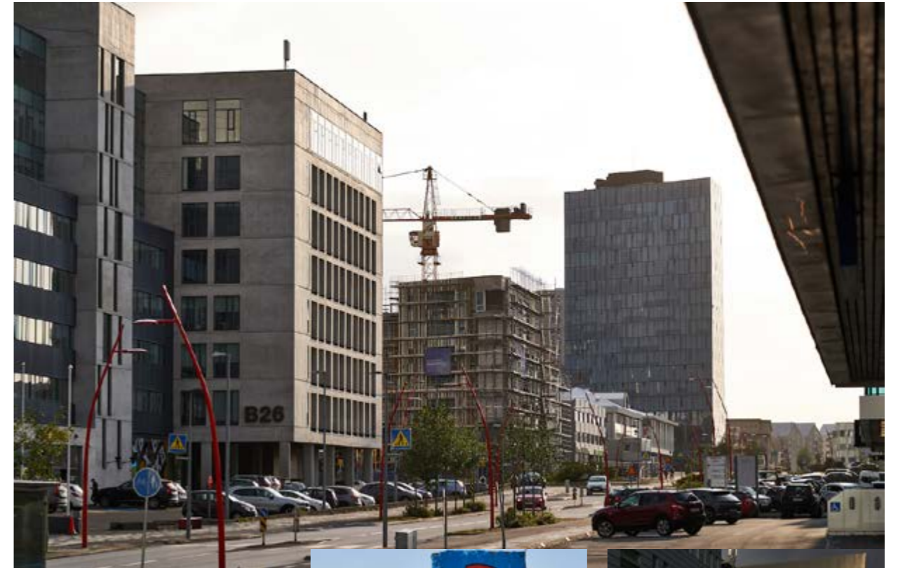
Það er enn verið að byggja og breyta Borgartúni
