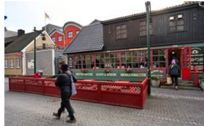
Hressingarskálinn, elsta húsið við Austurstræti byggt 1805
