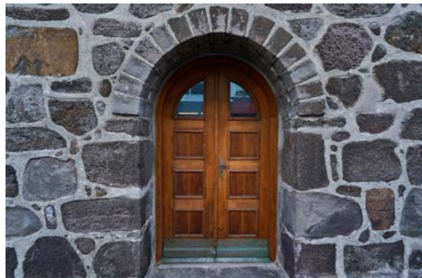
Inngangurinn inn í Hegningarhúsið á Skólavörðustíg
