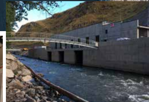
Vatnsaflsstöðin í Akhalkalaki séð að utan.
