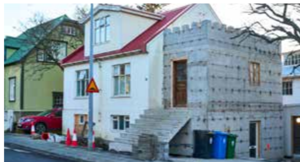
En er verið að byggja hús í kastalastíl í Reykjavík, hér nýbygging við Laufásveg
