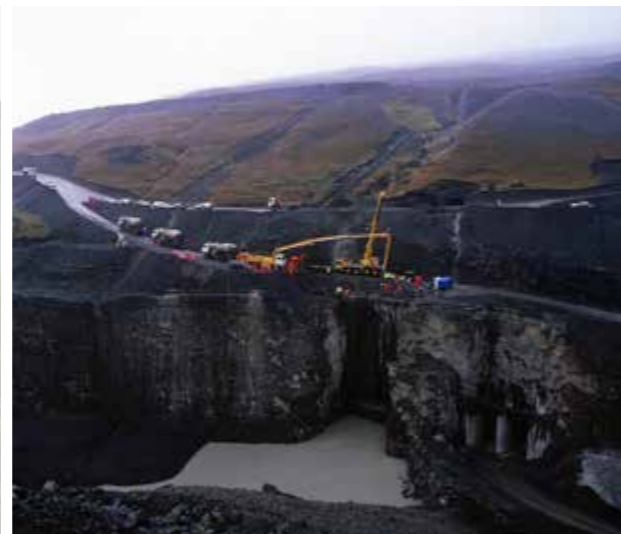
Frá byggingu Kárahnjúkavirkjunar, stærstu á landinu árið 2006
