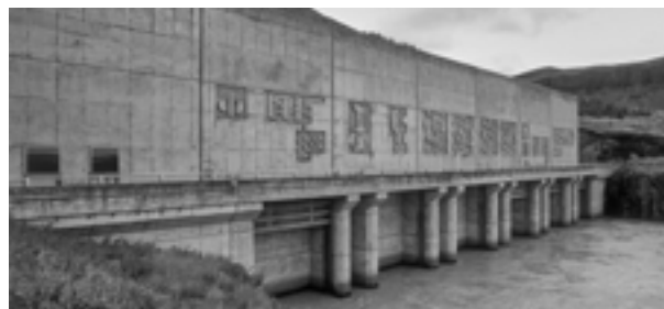
Búrfellsvirkjun in Þjórsá, dem längsten Fluss des Landes, seit 1969 ein Wahrzeichen der Bezirke Árnes und Rangárvalla im Süden des Landes, illustriert von Sigurjón Ólafsson
