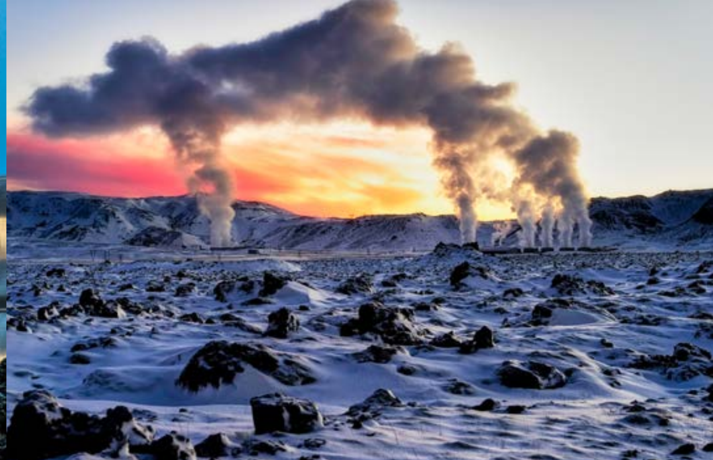
Svartsengi nabe Grindavík, der Bau des Kraftwerks begann 1976
