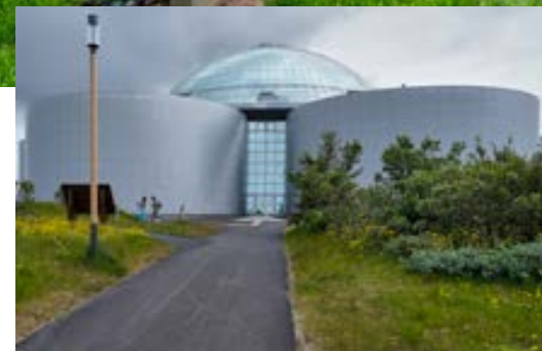
Perlan auf Öskjuhlíd wurde 1991 eingeweiht. Es beherbergt ein Museum, Restaurants und Warmwasserspeicher untergebracht und wird aktuell vom Reykjavík Stadtrat zum Verkauf angeboten.
